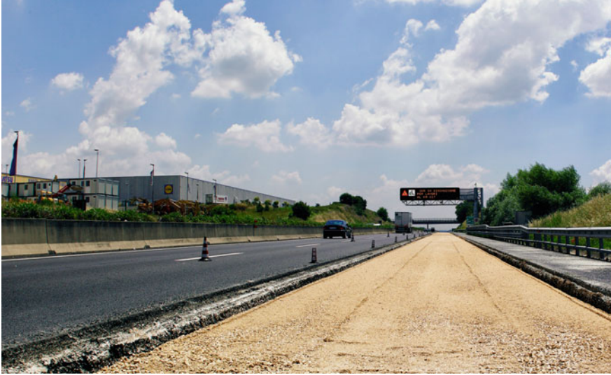
Fig. 1.3 Road works for deep renovation of asphalt pavement on A1 freeway, Italy (courtesy of Autostrade per l'Italia SpA, photo from Archivio Videofotografico Autostrade per l'Italia)
