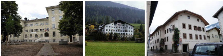
Fig. 6 (left to right): School building (SCH) Goetheschule of Bolzano/Bozen; hotel (HOT) “Drei Zinnen” of Sesto/Sexten; and rural restaurant (RR) “Schwarzer Adler” of Salorno/Salurn. Source Left figure: Monumentbrowser. Accessed at: http://www.provinz.bz.it/denkmalpflege/themen/1071.asp?status=detail&id=13947 . May 05, 2017. Middle figure: Monumentbrowser. Accessed at: http://www.provinz.bz.it/denkmalpflege/themen/1071.asp?status=detail&id=17342 . May 05, 2017. Right figure Monumentbrowser. Accessed at: http://www.provinz.bz.it/denkmalpflege/themen/1071.asp?status=detail&id=50551 . May 05, 2017
