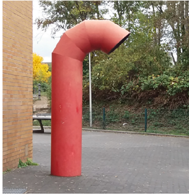
Fig. 4. Air ventilation pipe
