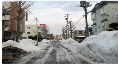
(d) sherbet road surface with potholes
