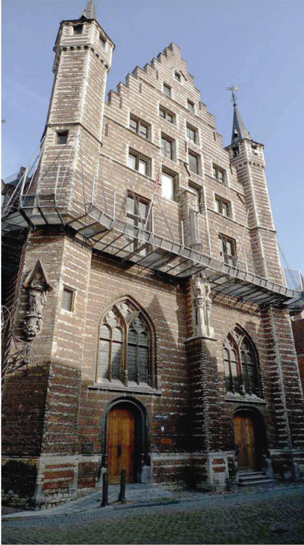
Fig. 11.1 Vleeshuis museum, main façade
