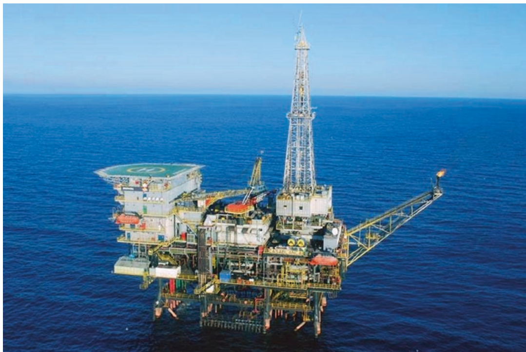
■ Fig. 2.13 Petroleum platform (Image courtesy of Pedro Cámara)
