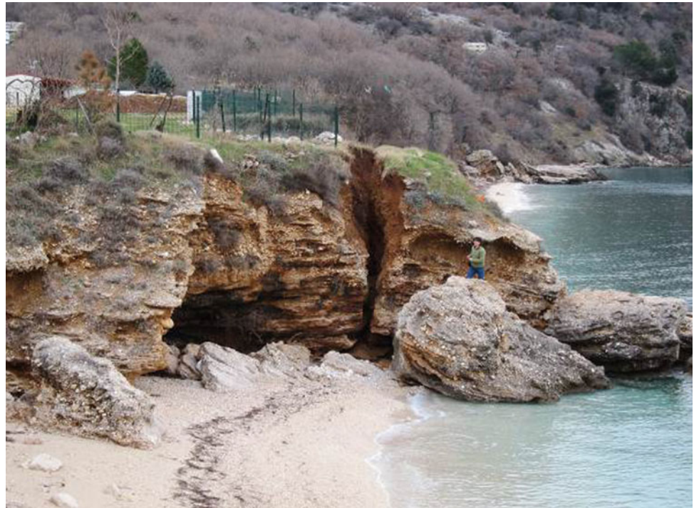
Fig. 6 The recent cliff collapse (photo Č. Benac)
