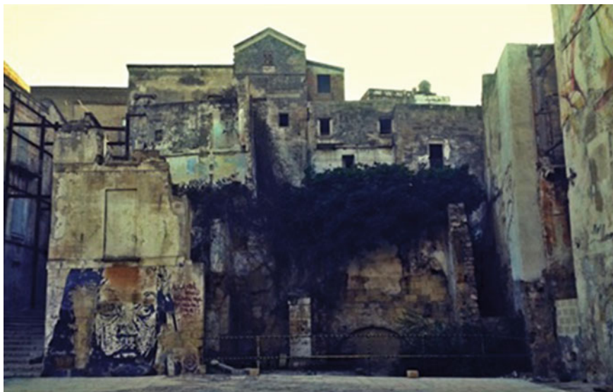
Fig. 9.2 Taranto, Città Vecchia. Environmental degradation. Source: Valentina Castronuovo
