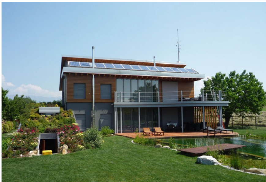
Fig. 10.6 Casa Zero Energy
