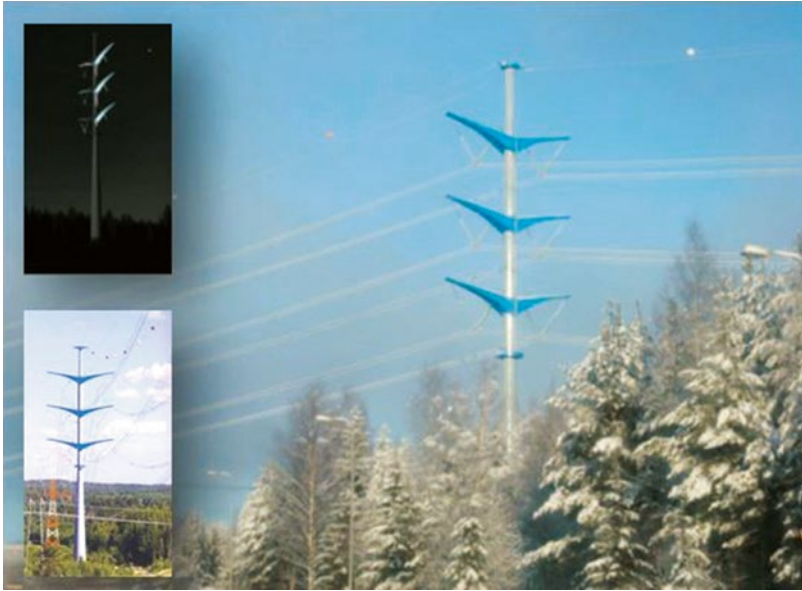
Figure 12.87 Lempäälä, Konehuone/J. Valkama.
