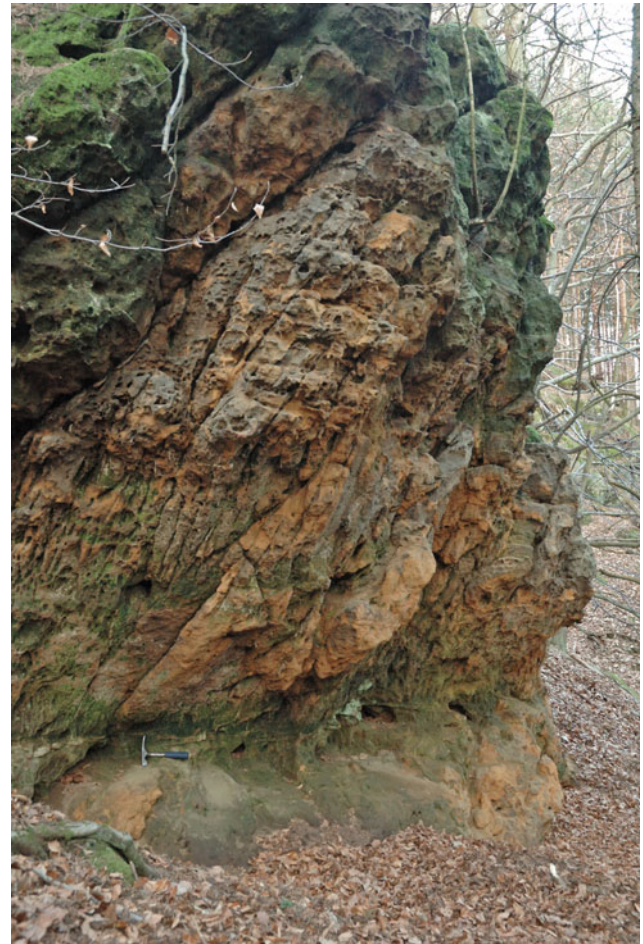
Fig. 13.4 A dense fracture zone accompanying a bedding-plane slip fault in Černý důl Valley W of Vrátnská hora (Photo J. Adamovič)
