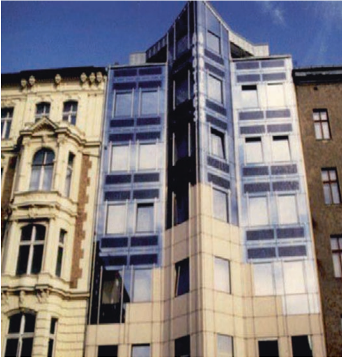
Fig. 18.15 Ökotec building in Berlin (Scheuten)
