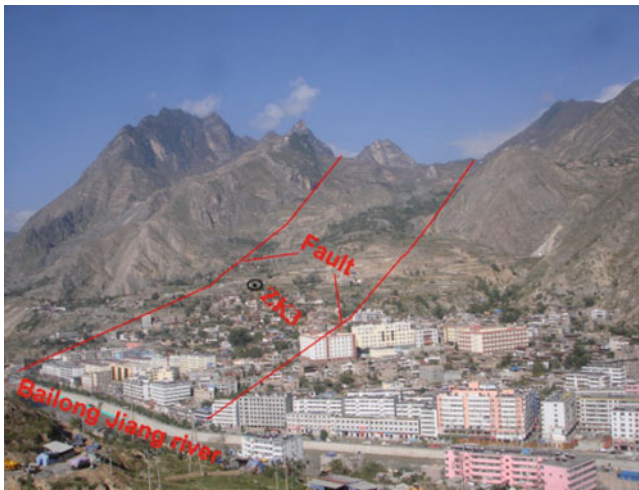
Fig. 1 View of the Suoertou landslide
