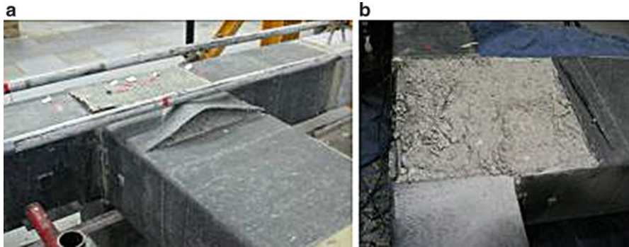
Fig. 14.11 T_FRP failure mode
