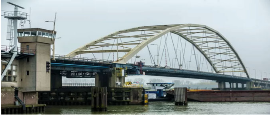
Fig. 1 Brug over de Beneden Merwede [13]
