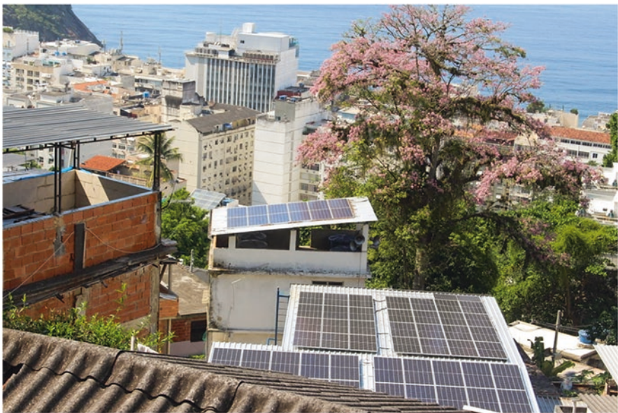
Fig. 26 Partial view of PV module installation in Babilônia community (Rio de Janeiro)
