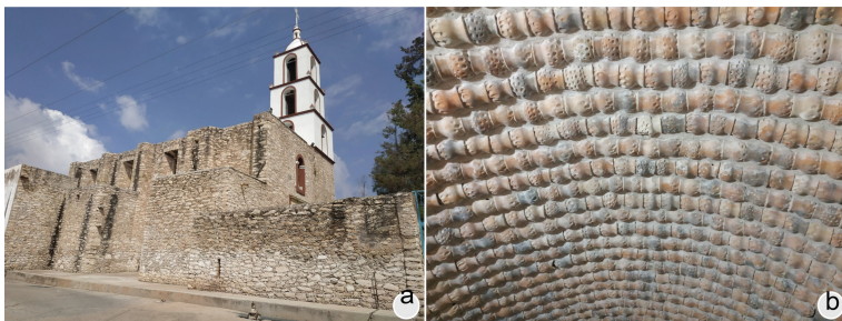
Fig. 1. a) Lateral View of the Temple Inmaculada Concepción. b) Cantaritos vault.
