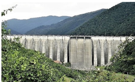
Fig. 13.103 Gura Râului dam
