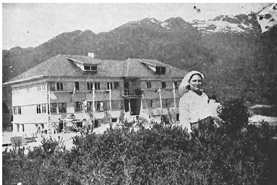
Otro aspecto del hotel en construcción
