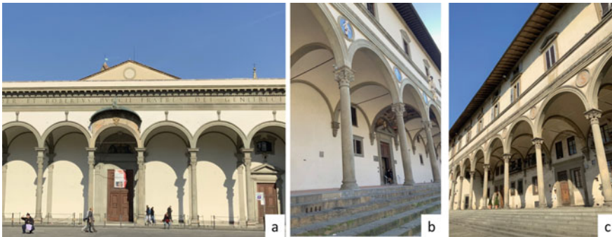
Fig. 21.3 a Santissima Annunziata basilica; b Spedale degli Innocenti; c Loggiato dei Servi di Maria. Columns, capitals, and arches are in Pietra Serena sandstone, stairway is in Pietraforte sandstone (Spedale degli Innocenti) and in Pietra Serena sandstone of Firenzuola (Marnosa Arenacea Formation) [4] (Loggiato dei Servi di Maria). Images are from the PWA [1]
