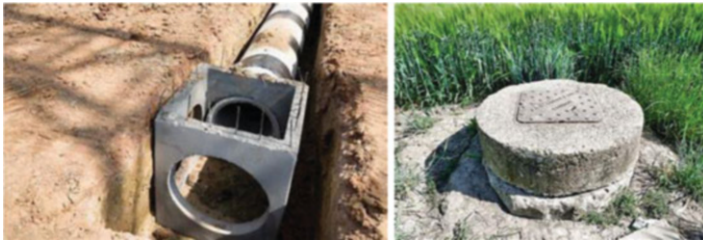
Fig. 2 Normal manholes
