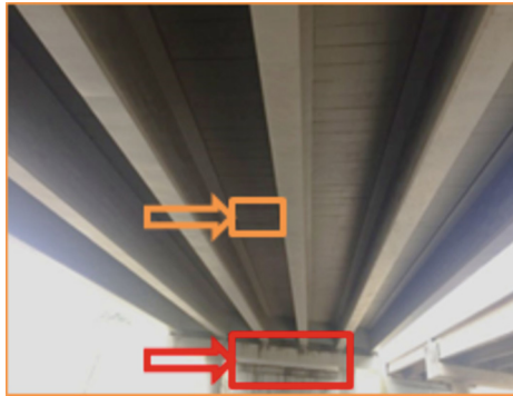
Fig. 7. Manoel Aveiro viaduct
