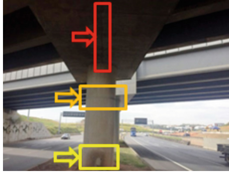
Fig. 6. Manoel Aveiro viaduct
