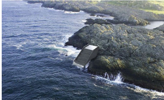
Fig. 14 Seawave slot cone generator (SSG)
