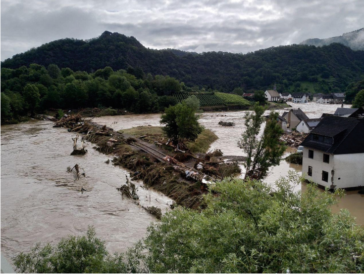
Fig. 1. Destroyed infrastructure in the Ahrtal, an adequate field for a sniffing IRC (source: https://de.wikipedia.org/wiki/Datei:Hochwasser_in_Altenahr_Altenburg.jpg )
