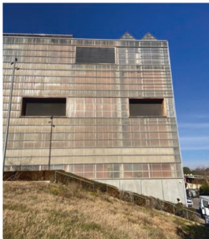
(d) Polycarbonate pyramids on the roof for daylight
