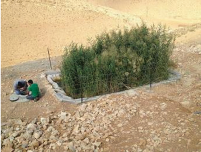
Fig. 4.4 Ramadin VF CW system for greywater reuse in Palestine
