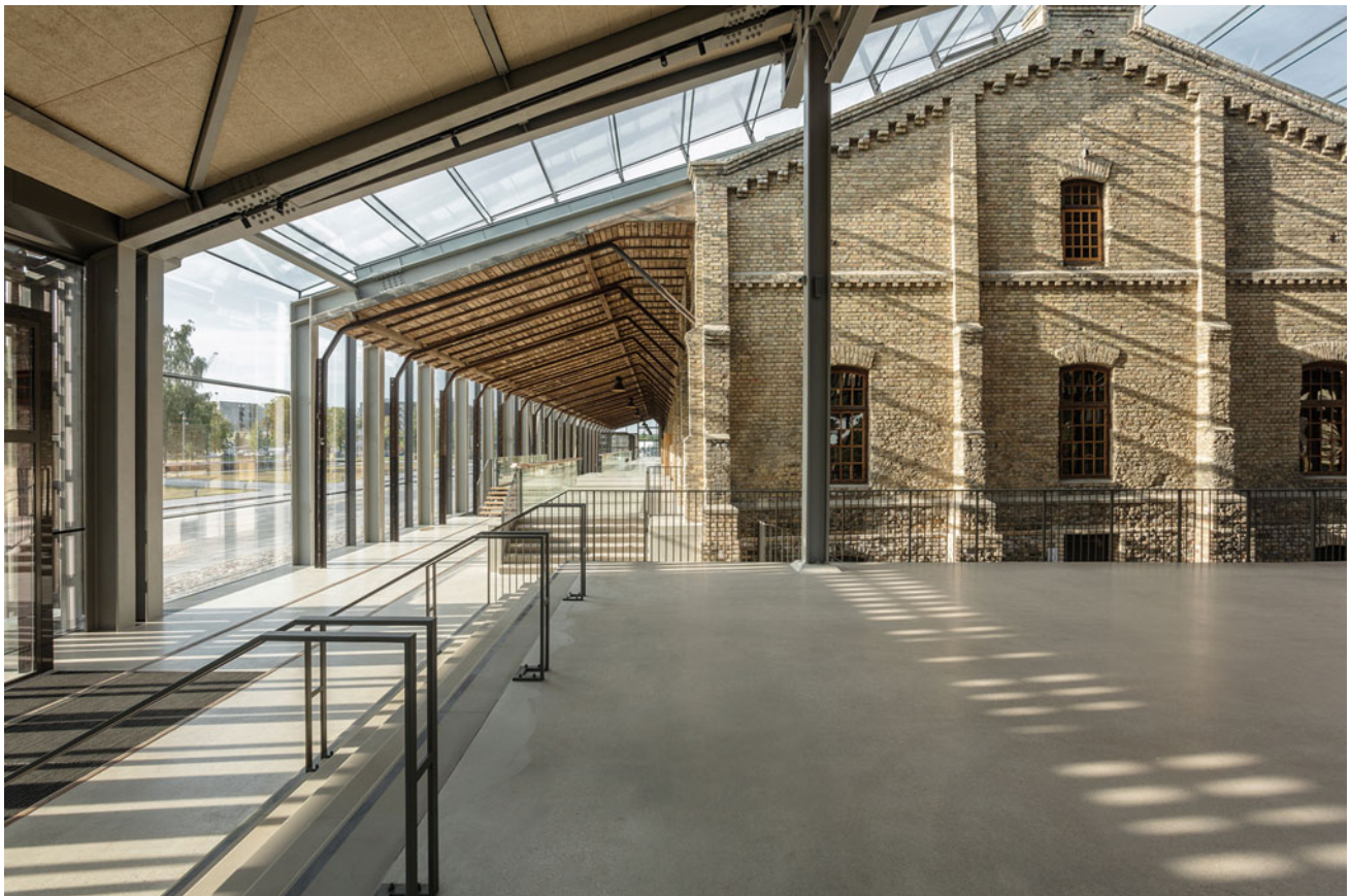
Fig. 1 Hanzas perons after the renovation (Sudraba Arhitektūra, 2018)
