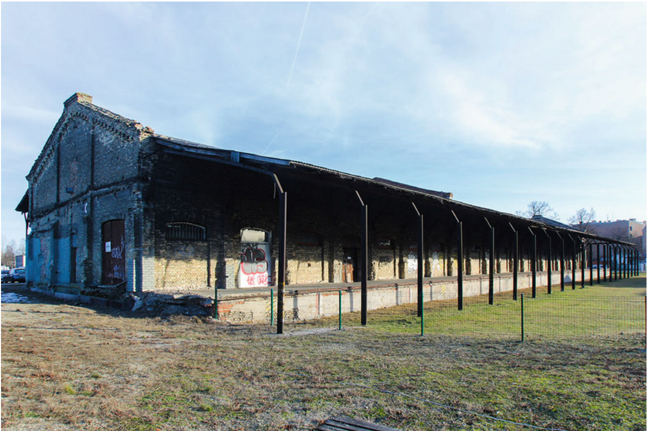
Fig. 4 Hanzas perons before renovation (Sudraba Arhitektūra, 2016)
