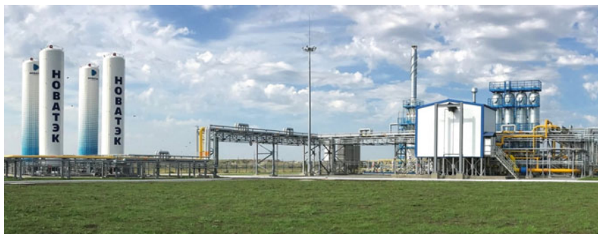
Fig. 1 NOVATEK LNG plant in Magnitogorsk
