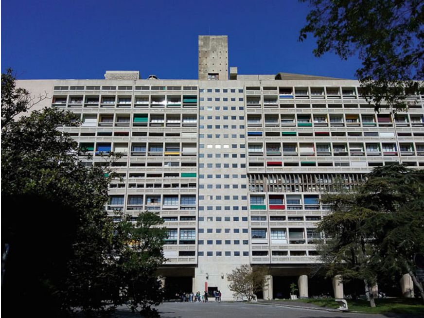
Fig. 2 Unite d'habitation, Marseille, France. Source https://commons.wikimedia.org/wiki/File:Unité_d%27habitation_Marseille,_France.jpg
