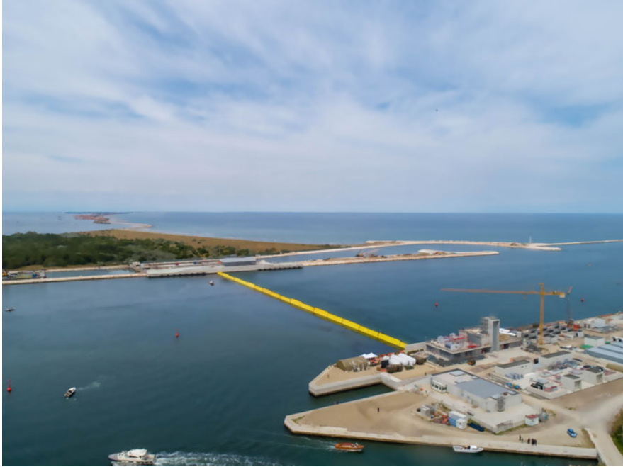
Fig. 7 Chioggia inlet. The mobile gates in operation (ph. DronExplore © Ministero delle Infrastrutture e della Mobilità Sostenibili—Provveditorato Interregionale per le Opere Pubbliche per il Veneto—Trentino Alto Adige—Friuli Venezia Giulia, già Magistrato alle Acque di Venezia—concessionario Consorzio Venezia Nuova)
