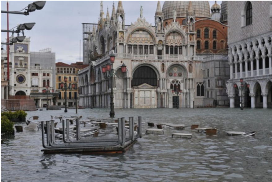
Fig. 4 Venice. High water: Piazza San Marco flooded (© Ministero delle Infrastrutture e della Mobilità Sostenibili—Provveditorato Interregionale per le Opere Pubbliche per il Veneto—Trentino Alto Adige—Friuli Venezia Giulia, già Magistrato alle Acque di Venezia— concessionario Consorzio Venezia Nuova)
