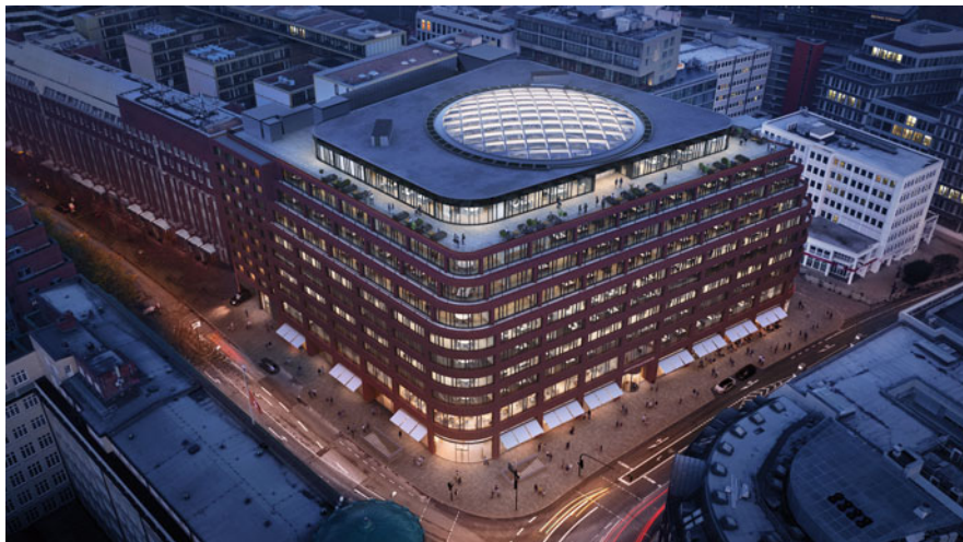
Fig. 1 Deutschlandhaus in Hamburg. Source: ABG Real Estate Group
