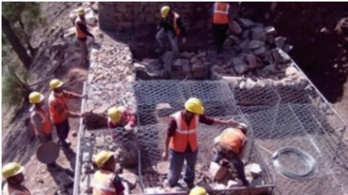
Fig. 8 Gabion filling
