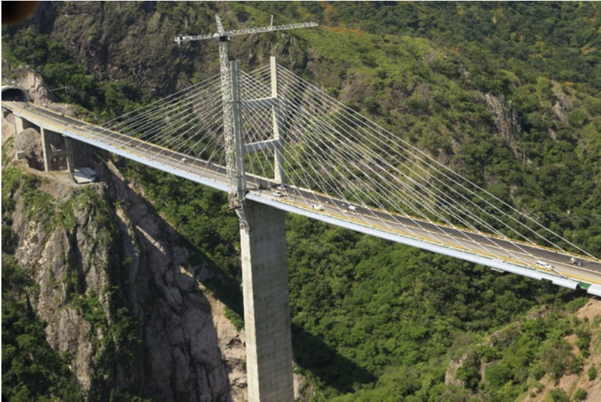
Fig. 1 El Carrizo Bridge
