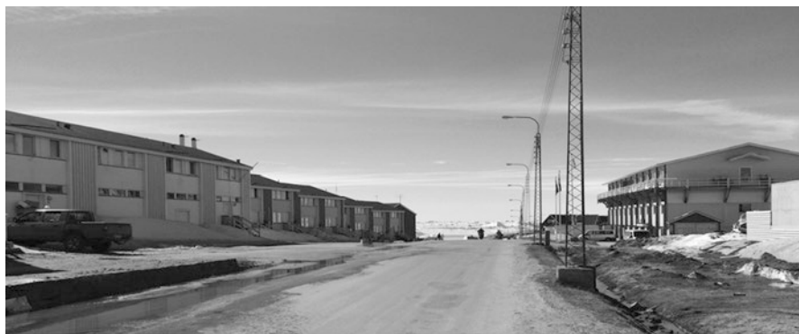
Fig. 10.4 Ilulissat town centre. (Picture: Gisele M. Arruda)
