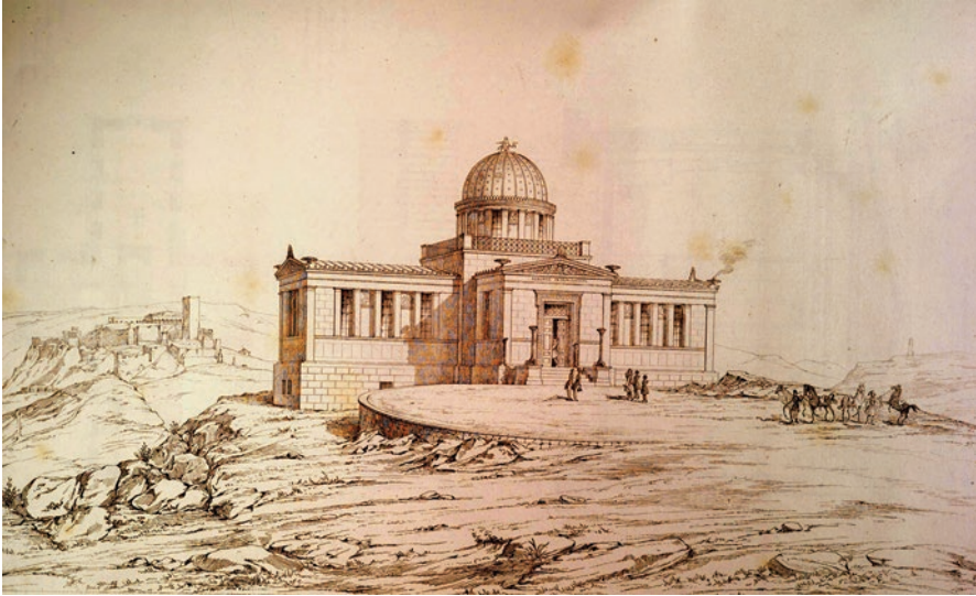
Fig. 5 Observatory in Athens (1846) (Hansen, Theophil (1846) Die Freiherr v. Sina'sische Sternwarte zu Athen , Allgemeine Bauzeitung Wien 11, pp. 126–131, T. 29)
