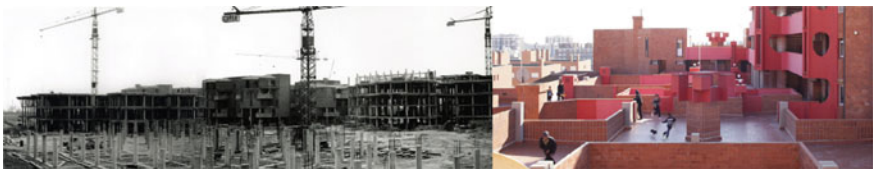
Fig. 2 Barrio Gaudí (1970–1971); ©HASXX_Tarragona http://arquitecturatarragona
