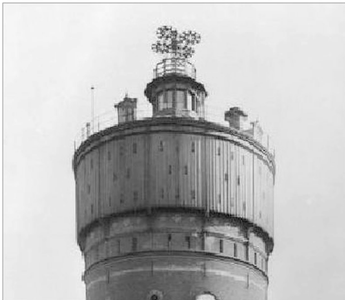
Fig. 12.5 Time discs in Rotterdam ( https://nl.wikipedia.org/wiki/Watertoren_(Rotterdam_Delfshaven) ).
