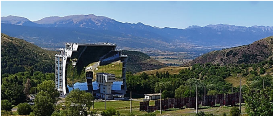
Fig. 36.4 Four Solaire Font-Romeu-Odeillo-Via in 2010. Photo H.Zell (CC BY-SA 3.0)
