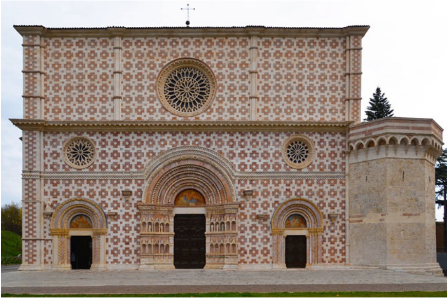
Fig. 1 Basilica of Collemaggio, L'Aquila: the facade
