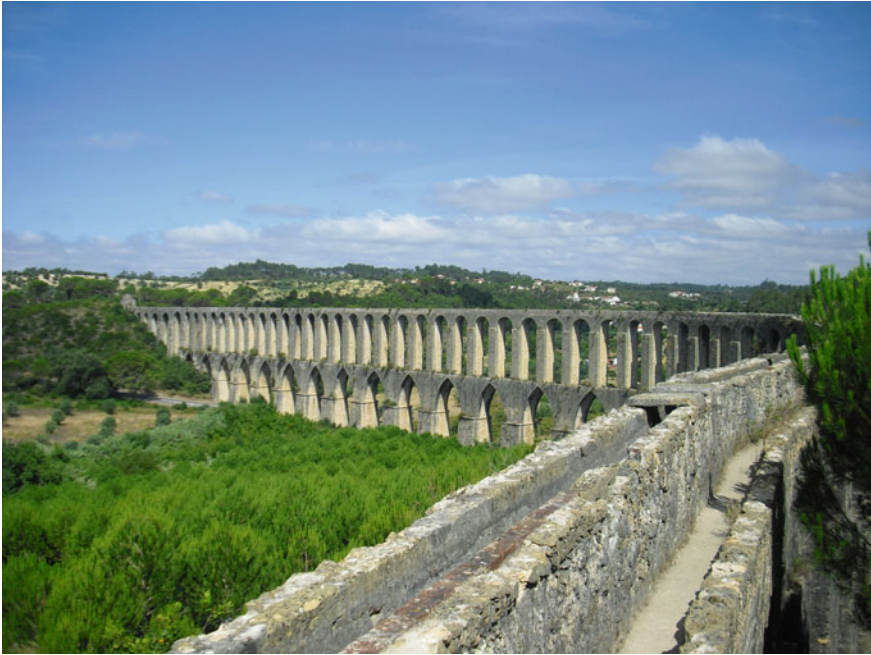
Fig. 10 The Aqueduto dos Pegões Altos, Tomar, 1593–1619, designed by Filippo Terzi. Photo Wikimedia Commons
