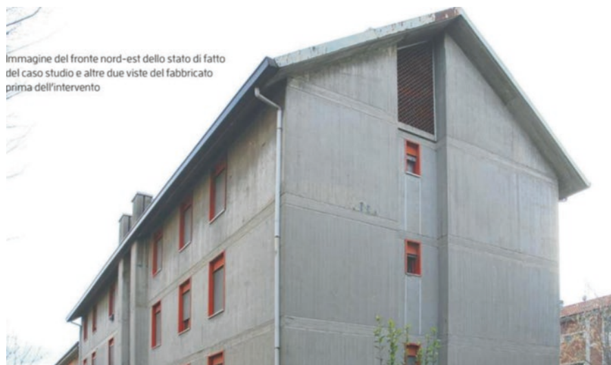
Fig. 22.5 View of the north-east wall of the demonstration building. Source: “Soluzioni prefabbricate per la riqualificazione energetica dell’involucro” by Graziano Salvalai, aZero n. 20, pp. 56–69—EdicomEdizioni
