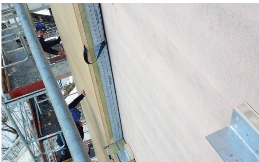
Fig. 22.12 Laying of the façade elements. Source: https://www.agenziacasaclima.it/it/progetti-di-ricerca/sinfonia/sinfonia-risanamento-via-passeggiata-dei-castani-1783.html
