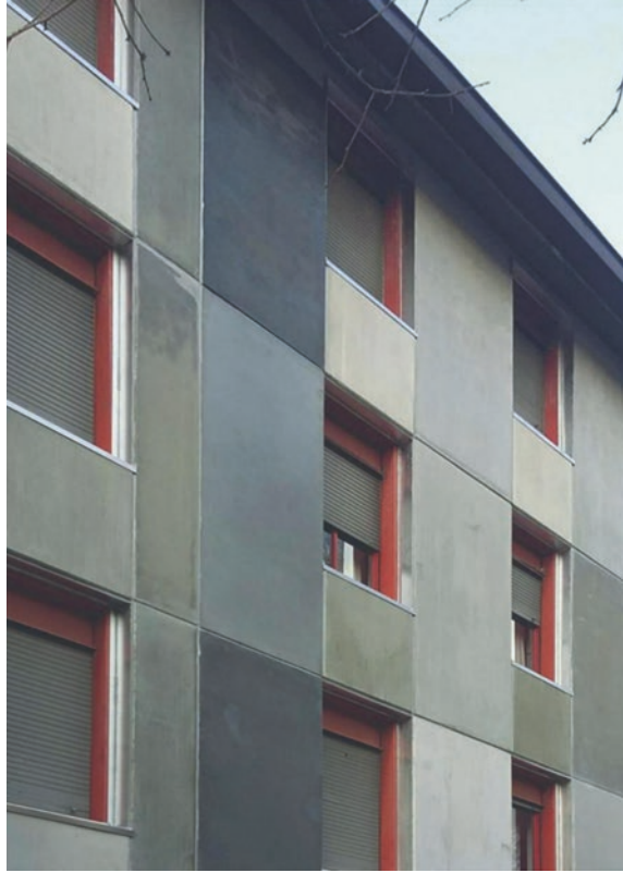
Fig. 22.7 View of the final result. Source: “Soluzioni prefabbricate per la riqualificazione energetica dell’involucro” by Graziano Salvalai, aZero n. 20, pp. 56–69—EdicomEdizioni
