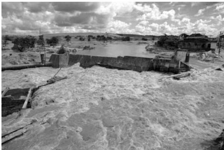
Fig. 3 Broken dam resulting from the 2010 floods in the Ríó Largo city. (Source: http://veja.abril.com.br/noticia/brasil/a-origem-do-tsunami-que-varreu-o-nordeste )
