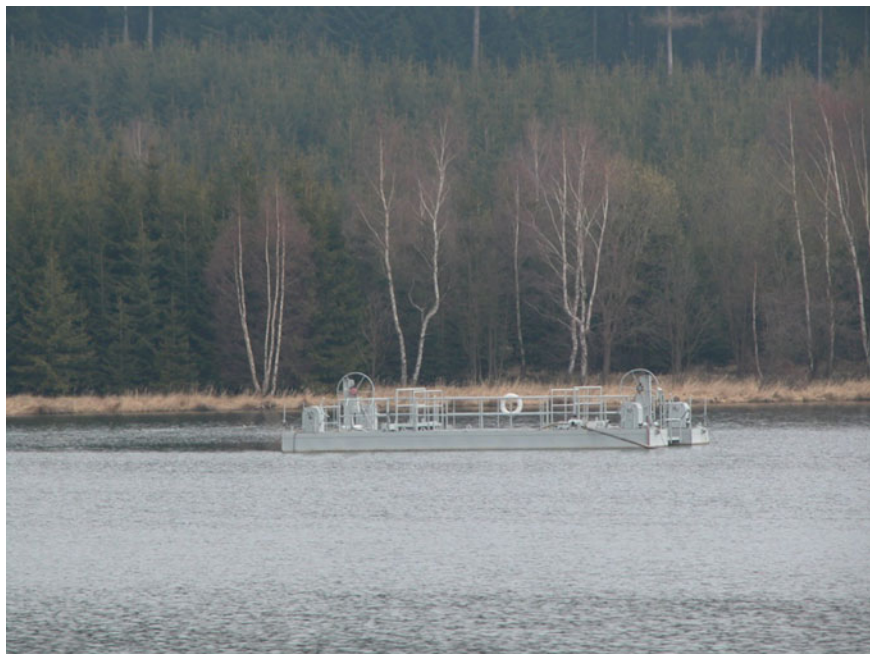
Fig. 7.3 Surface aeration equipment in Nová Říše reservoir
