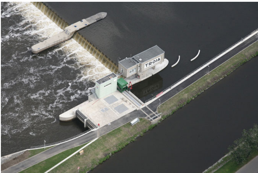
Fig. 15.24 View of SHPP Troja (source Povodí Vltavy, s.p.)
