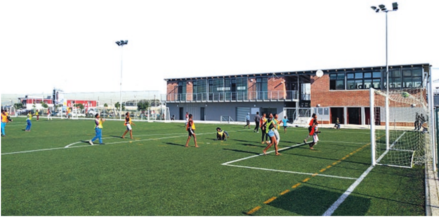
Fig. 8.7 Safe-Hub Gugulethu/Manenberg, 2016. © VPUU NPC
