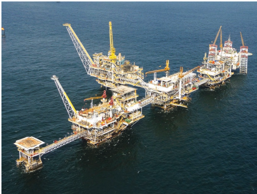
Fig. 12.1 Oil platform in Cabinda (Angola). (Photo: Laurindo Inglês)
