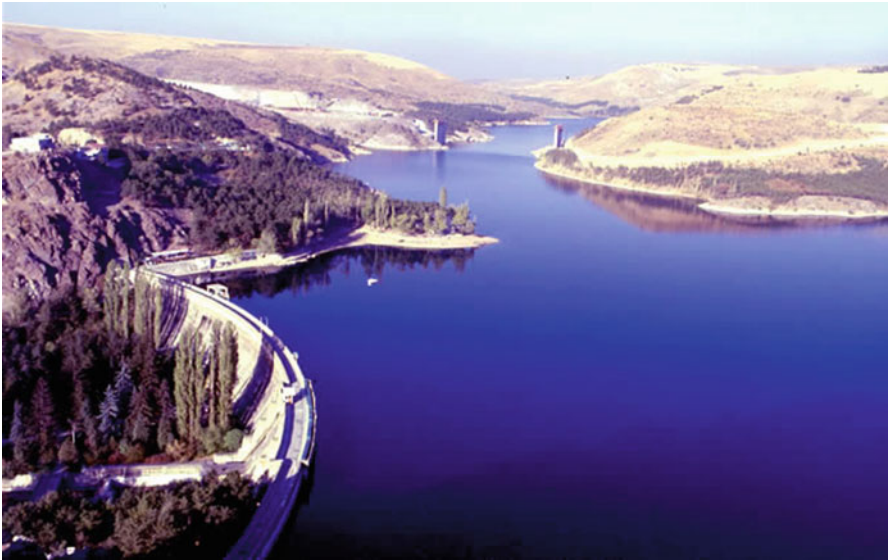
Fig. 3.4 Cubuk-1 dam. (DSI 2018b)
