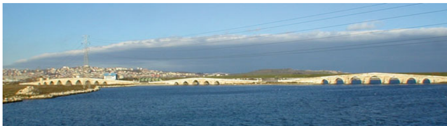
Fig. 2 The Büyükçekmece bridge (© Orlandi)
