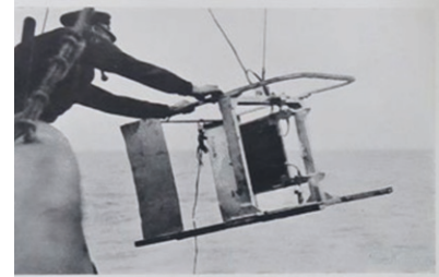
Fig. 130. Bodemstroommeter voor stroomen op 0,15 en 0,50 m ± bodem.
