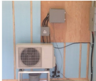
(d) Fully Instrumented Outdoor Unit
