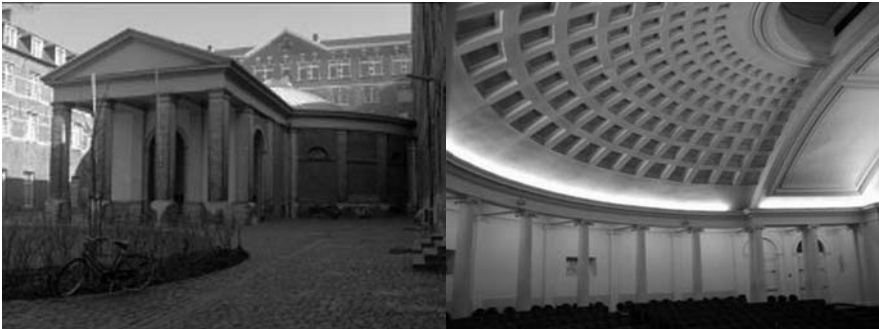
Figure 8.1a-b. The Grote Aula: exterior (photo: K. De Leye & E. Dooms) and interior (photo: M. Rychtáriková)
